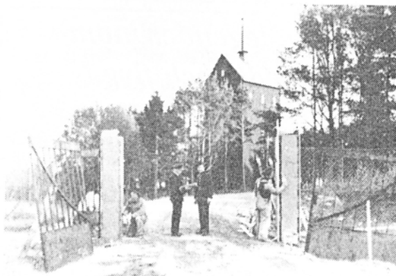
Genom denna grind, nu färdigbyggd, passerade Artur. I bakgrunden det "höga" vattentornet.
